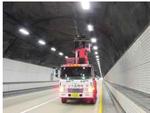
고소작업차를 활용한 라이닝 근접조사
